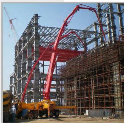
Вместе с тремя автобетононасосами серии 36 «новичок» усердно перекачивает бетон.
